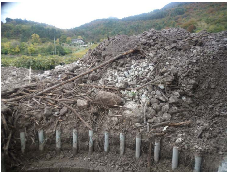
L'invaso "vecchio" costruito una decina d'anno or sono dopo una delle tante esondazioni del rio Scanupia
