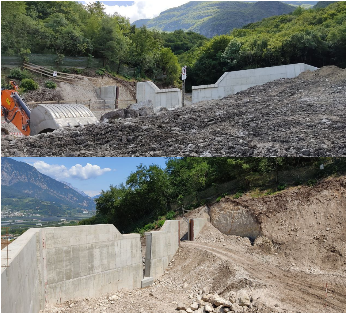
Intervento dei Bacini Montani- primavera 2021. Uno degli invasi in via di costruzione sul rio Scanupia
